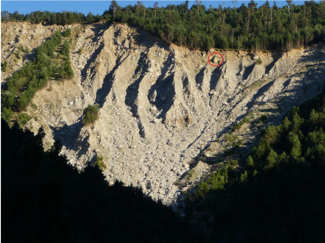
Figura 40: Bloque estudiado ubicado en la zona de escarpe. 2010.
