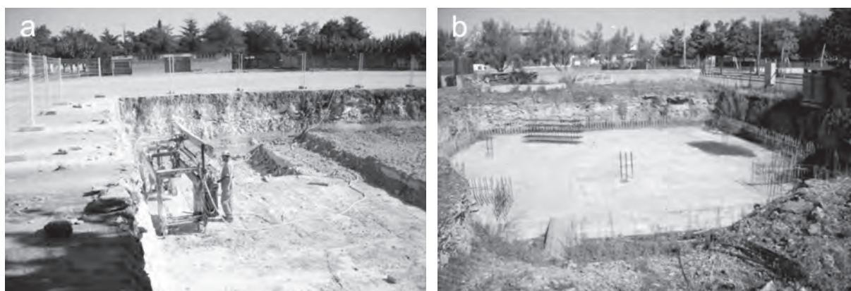
Figura 2. Imágenes del área de Mata, al sur de Banyoles. a) Explotación de travertino aprovechando la construcción de la cimentación de una edificación. b) Orificio dejado por una constructora a partir del que se han explotado los travertinos, de alrededor de 2m de potencia que cubrían el área.
