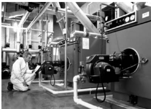
Figura 6.15. Bateria de calderes d'aigua calenta amb subministrament de gas natural.
