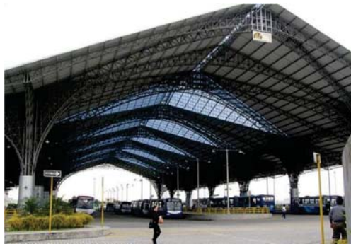
Figura 5. Estación de integración, Río Daule. (Skyscrapercity, Infraestructura y medios de transporte)
