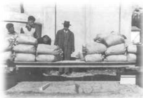
Ensayo de carga de viguetas pretensadas, España 1950.
