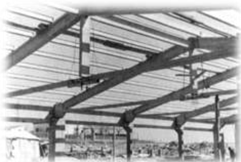
Cercha con viguetas pretensadas, España 1950.
