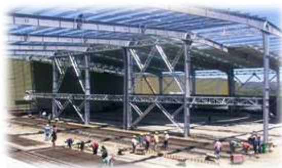
Figura 13: Estructura industrial metálica
