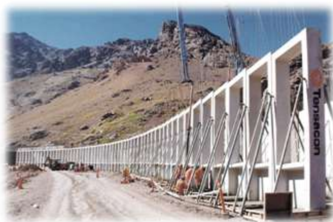
Figura 12: Pórticos prefabricados - Fuente: Tensacon.cl
