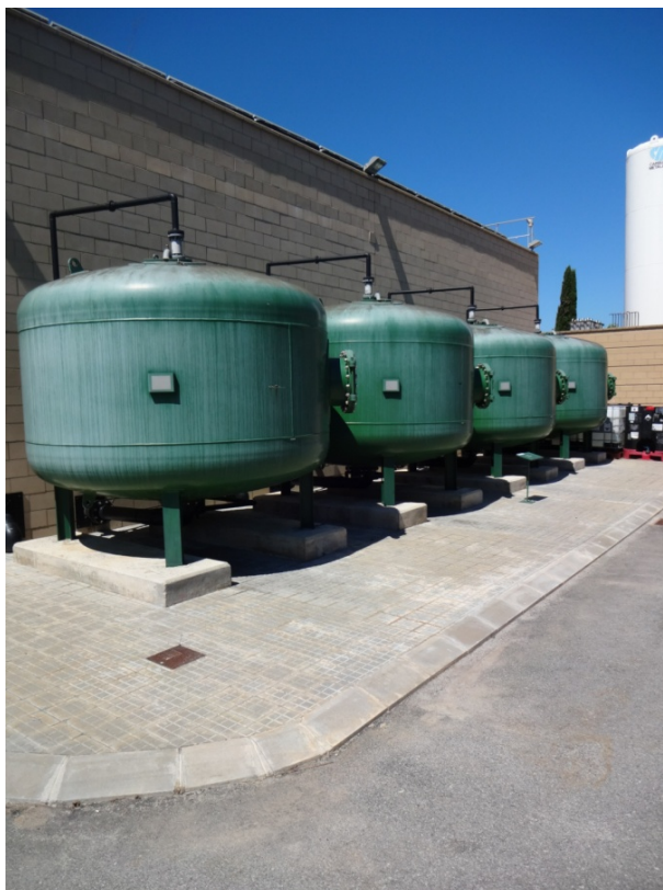
Figura 4.4.2.5. Foto dels quatre filtres tri-capa
