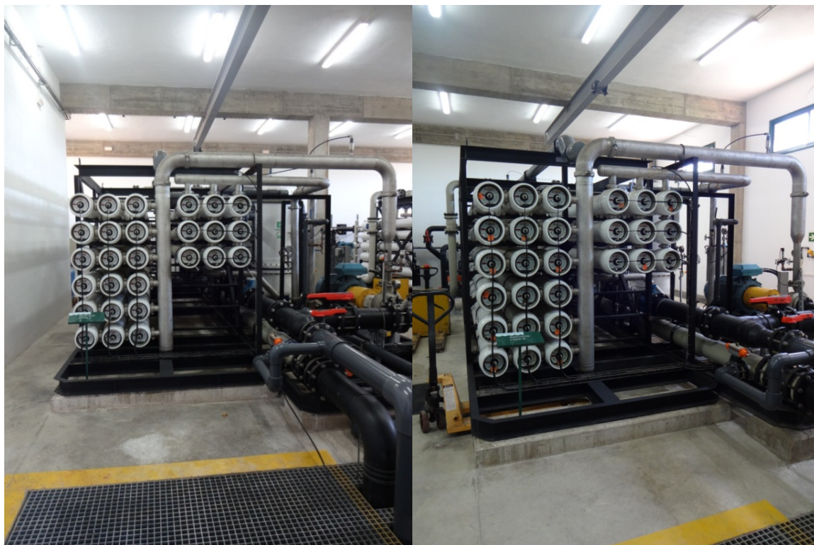
Figura 4.4.2.7. Foto de les línies A i B d'osmosis de l'ETAP Mas Blau
