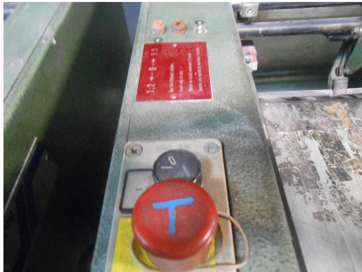
Figura 7. Cuadro mandos Marcador. Formado por seleccionador y Paro de Emergencia.
