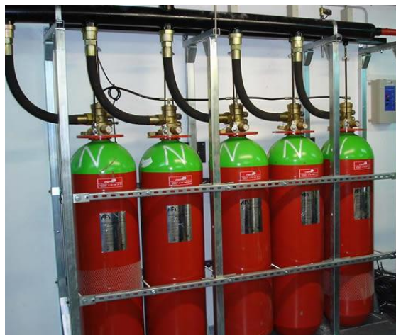
Figura 41 Sistema de cinc ampolles de gas inert d'un sistema de contra incendis.
