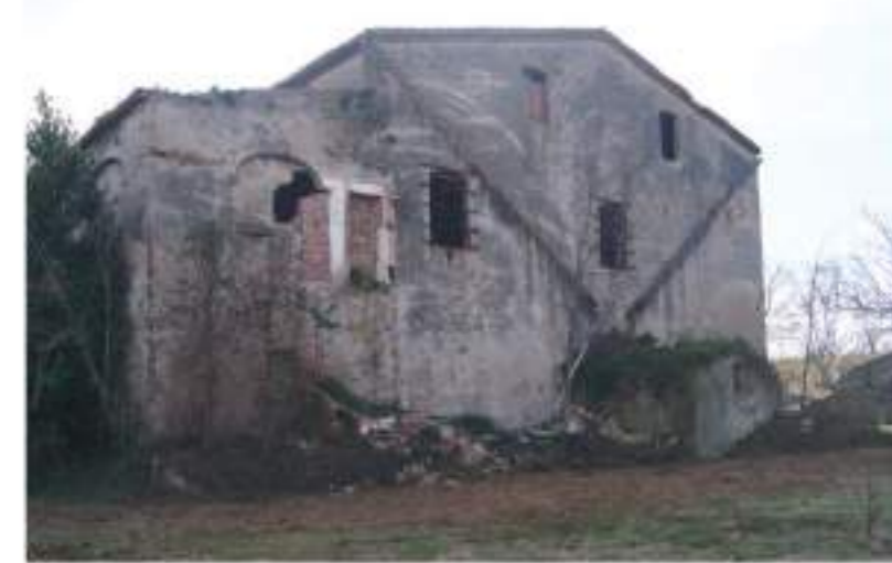
Façana Nord i dipòsit cisterna i baixants de teulada
