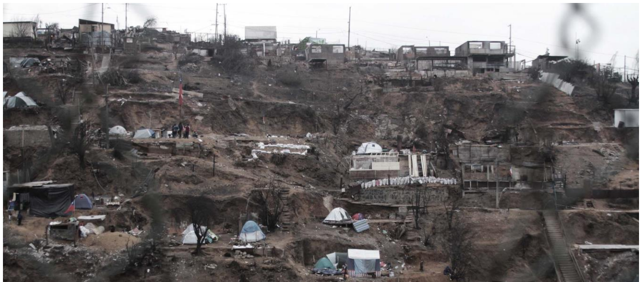
Fig. 1 Reocupación de una zona afectada por el incendio en Valparaíso. Valparaíso, 2014.
