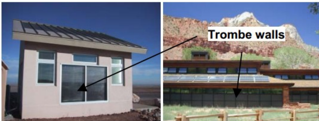
Figura 5.9: Instal·lacions a NREL (esquerra) i Zion National Park (dreta).
