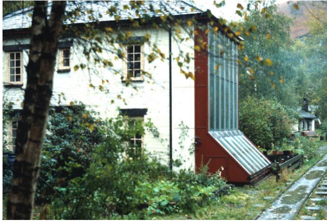
Figura 5.3: Mur Trombe a Gal·les, Regne Unit.
