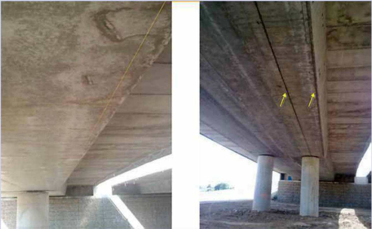
Figura 10.- Fibras longitudinales instaladas
