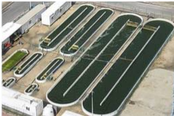
Figura 5.7.2. Ejemplo de FBR abierto tipo “ raceways ”. (Fuente: Spirulina algae)
