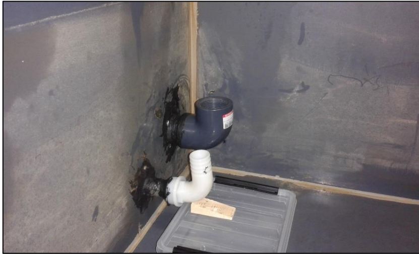
Figura 43. Colzes utilitzats per omplir les canonades amb vinagre.
