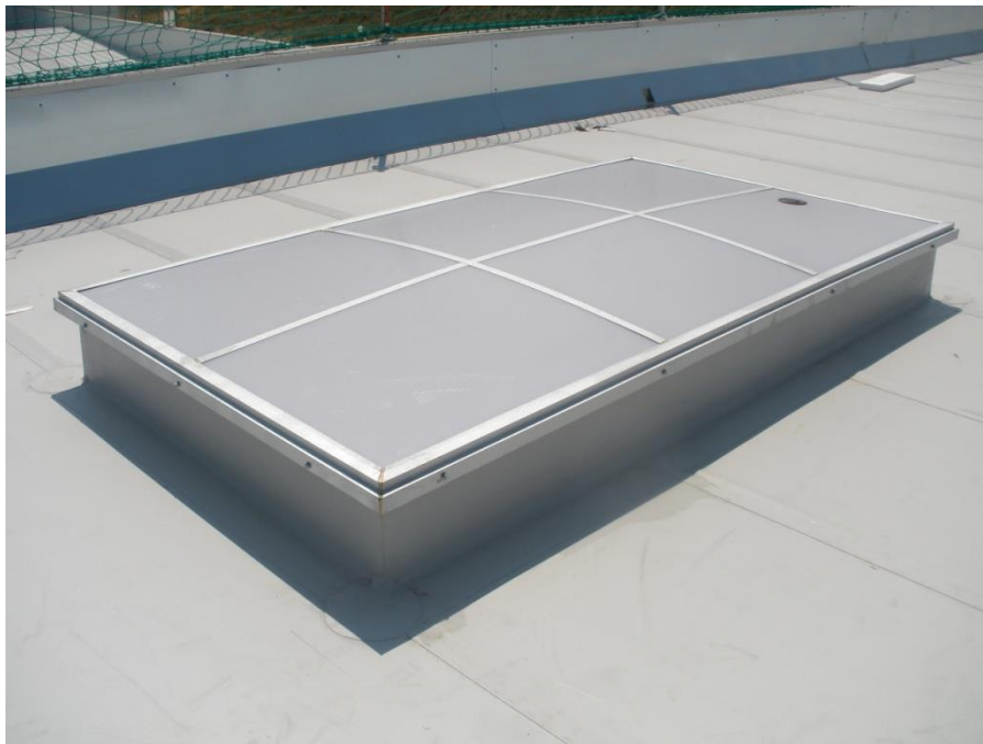
Figura 1: Claraboya en el techo de un edificio [8]
