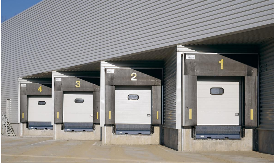
Figura 3: Puertas de los muelles de carga y descarga de camiones [10]
