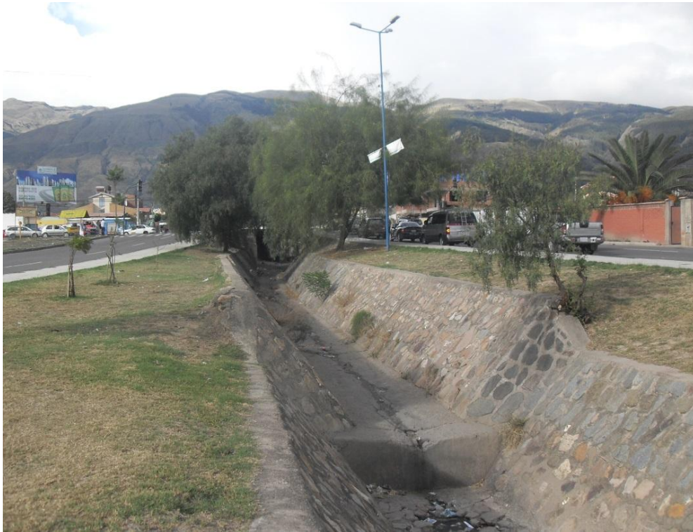
Grafico No 2. Torrentera Pintu Mayu canalizada al norte de la ciudad, (imagen propia).
