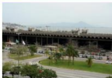
09 - Terminal Rodoviário Rita Maria
