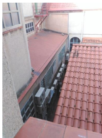
Figura 41 – Fachada patio pequeño este.
