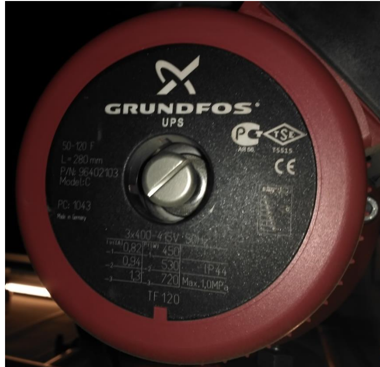
Figura 22 – Detalle de la chapa de una bomba de recirculación.
