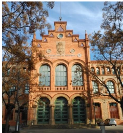
Figura 38 – Fachada Oeste 3 (entrada principal).
