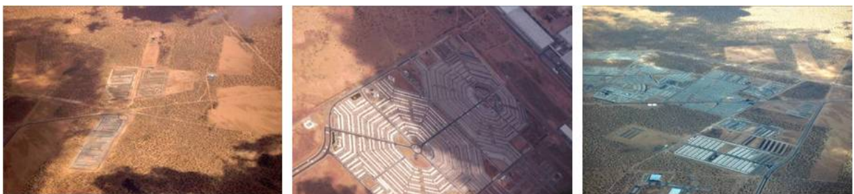
Figura 4. Fraccionamientos habitacionales de vivienda social en proceso de construcción al sur de Ciudad Juárez
