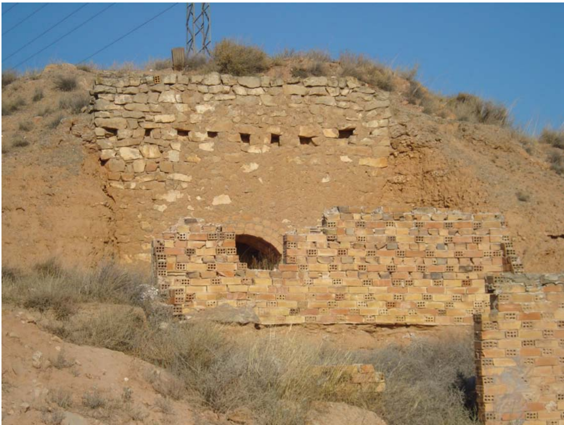
Restos del horno y de un edificio aledaño al mismo.
