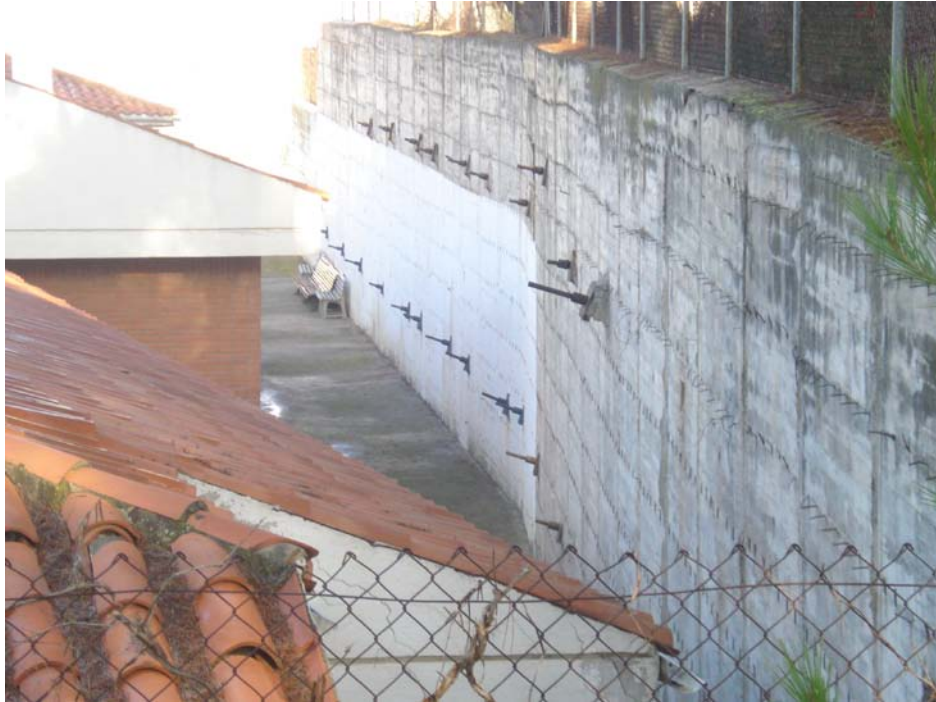
La guarderia i els murs amb els anclatges
