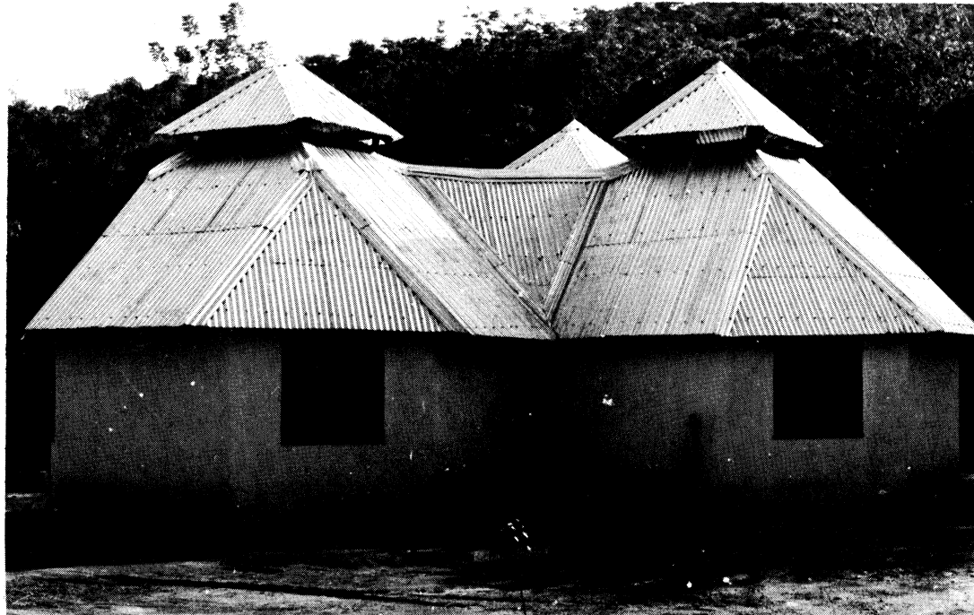
Figure 15. Small office building in Mali-Africa, consisting of 3 units based on the rhombicuboctahedron. ● Petit immeuble de bureaux au Mali en Afrique, consistant en 3 modules basos sur le rhombicuboctaèdre.
