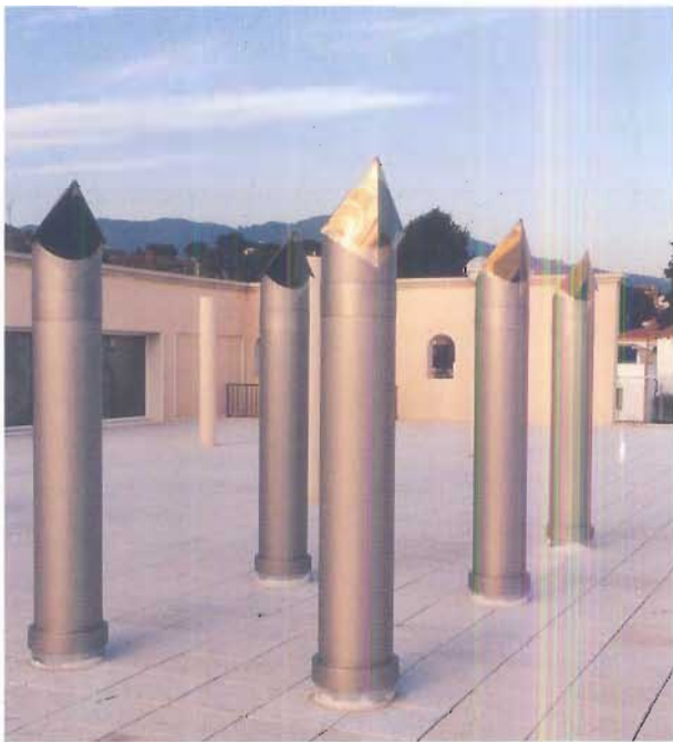
Instal·lació de conductes de llum al Masnou
