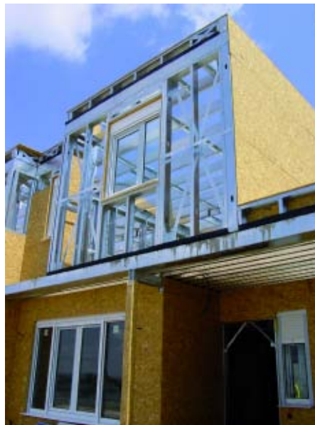
FOTO A la fotografia, habitatges construïts amb estructures metàl·liques lleugeres a Àvila.
