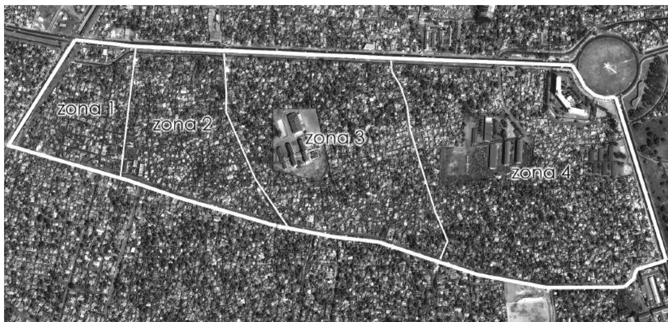
Figura 1 Fotografía aérea del barrio de Maxaquene 'A' en Maputo, Mozambique
