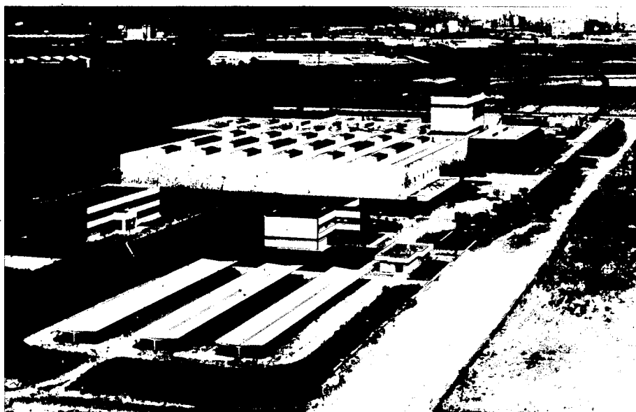
Vista aérea de la fábrica y almacén general en: Poligon Industrial Pratenc El Prat de Llobregat
