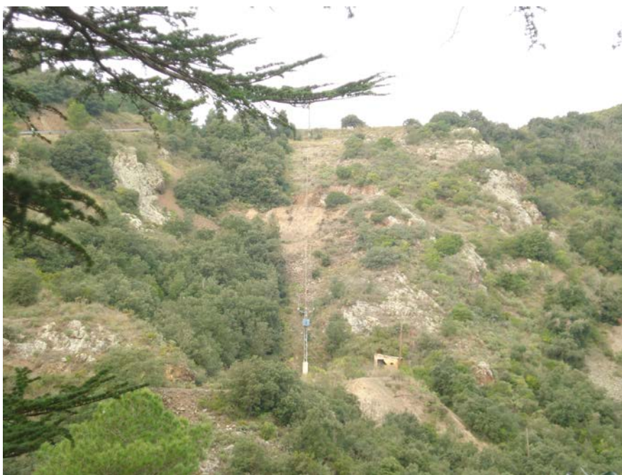
Fotografia 2. Un aspecte de les antigues explotacions mineres del barranc d'Escornalbou , situades per sota del Castell d'Escornalbou
