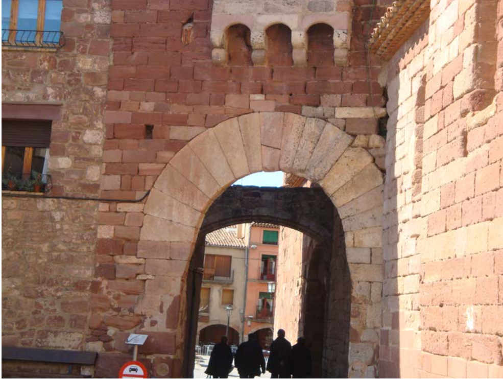
Fotografia 6. Porta de Prades i façana de l'església, amb carreus dels materials del Buntsandstein. Dintre de la plaça, es poden veure diversos edificis, amb característiques semblants als de la façana de l'Església
