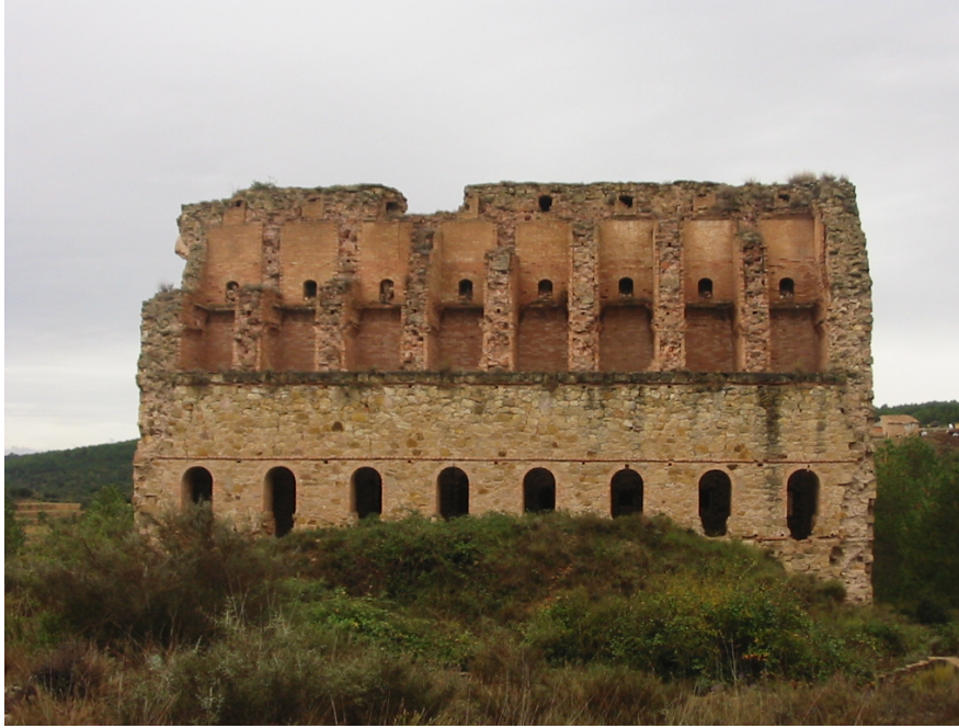
FOTOGRAFIA 6. Zona dels forns de calcinació dels materials bituminosos. Mines de Rubielos de Mora
