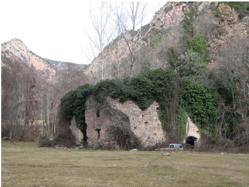
Fotografia 2. Situació de la Farga Catalana , entre els afloraments de les calcàries del Devonianà
