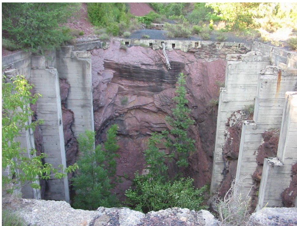
Fotografia 2. Base d'un dels ponts, per on circulava la línia fèrria, que anava de les mines cap a les tremuges.
