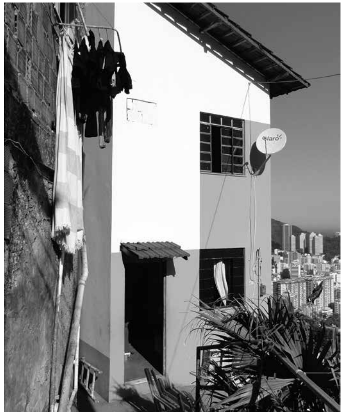
Fig.4: Vista del acceso a la vivienda – Vivienda Doña Rosa.
