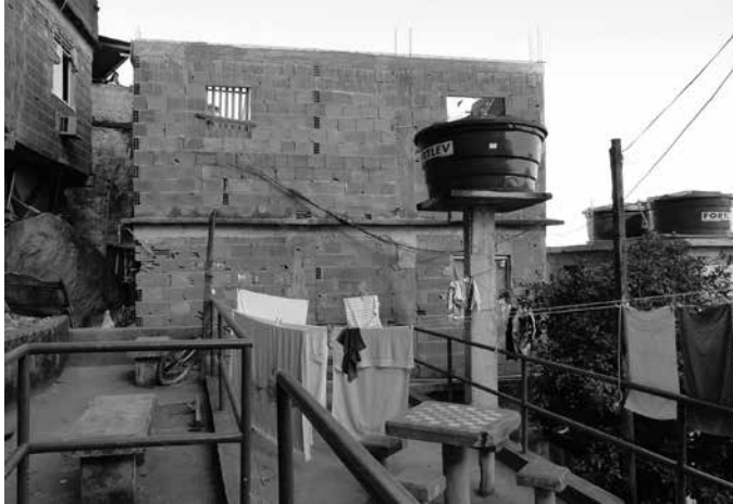
Fig.5: Vista desde la plaza de la fachada lateral – Vivienda Francisco
