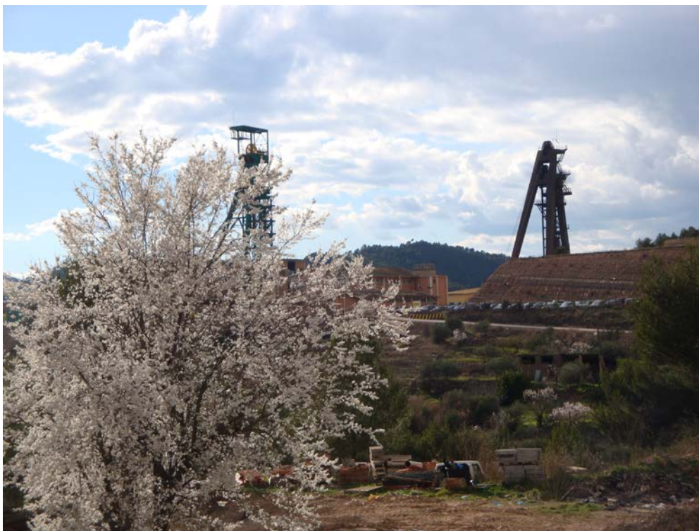
Fotografia 15. Els castellets del Pou 2 i del Pou 4 , de les Mines de Súria d'IBERPOTASH, a Súria
