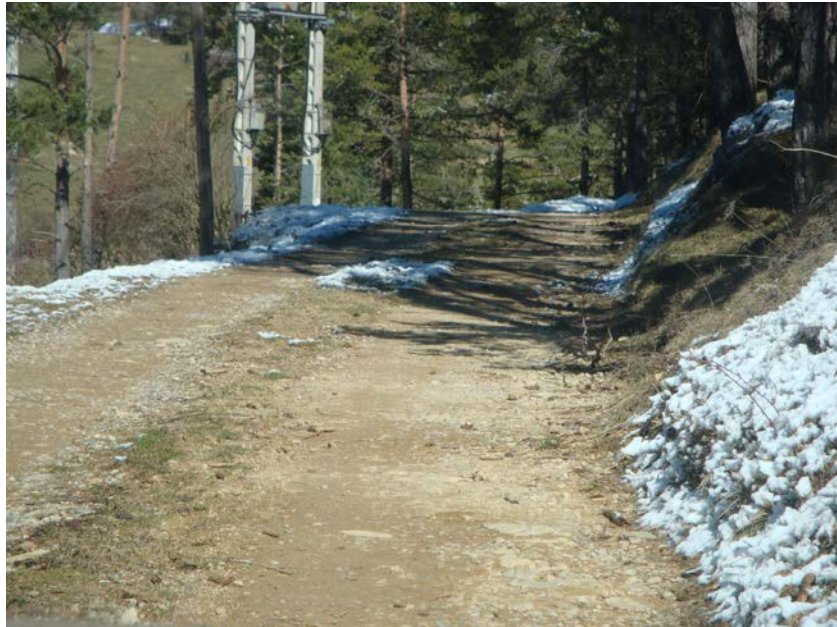
Fotografia 10 Plataforma del ferrocarril miner del Coll d'Oreller
