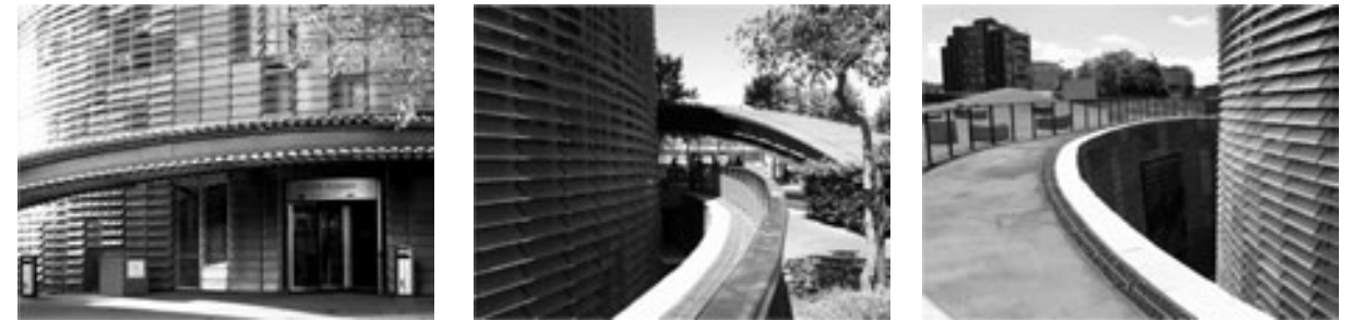
TORRE AGBAR, ATELIERS JEAN NOUVEL, BARCELONA. CONTACTE DE L'EDIFICI AMB EL PLA TERRA.
