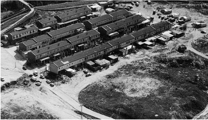
BTE La Quinta, ampliaciones irregulares. Febrero de 1998, Madrid- España. Fotografía aérea facilitada por el IRIS. Madrid- España.
