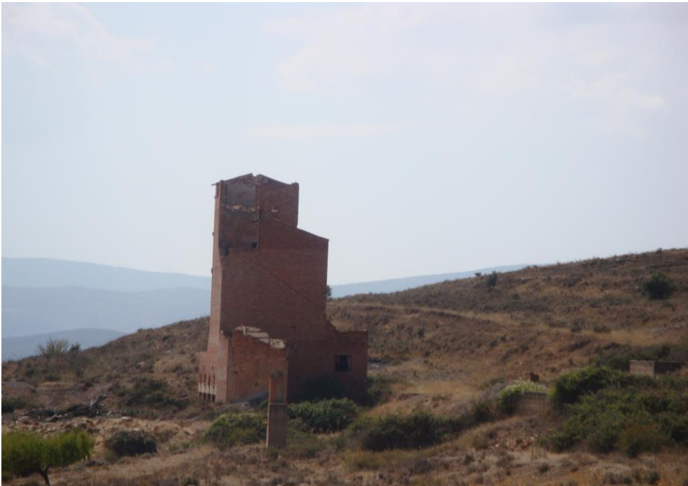
FOTOGRAFÍA 2 Restos de las instalaciones mineras de Villarroya
