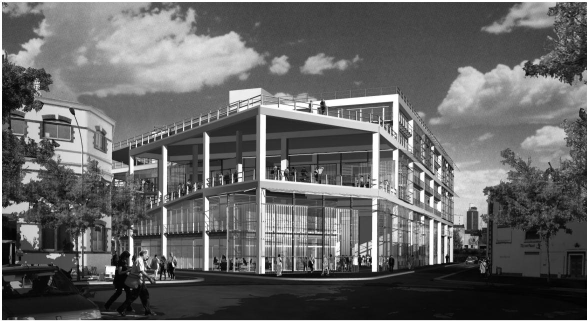
▲ Escuela de Arquitectura de Nantes, 2009
