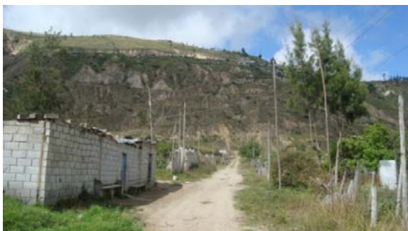
Foto 4. Vista de una calle tipo del barrio 4, Abril 23 de 2011
