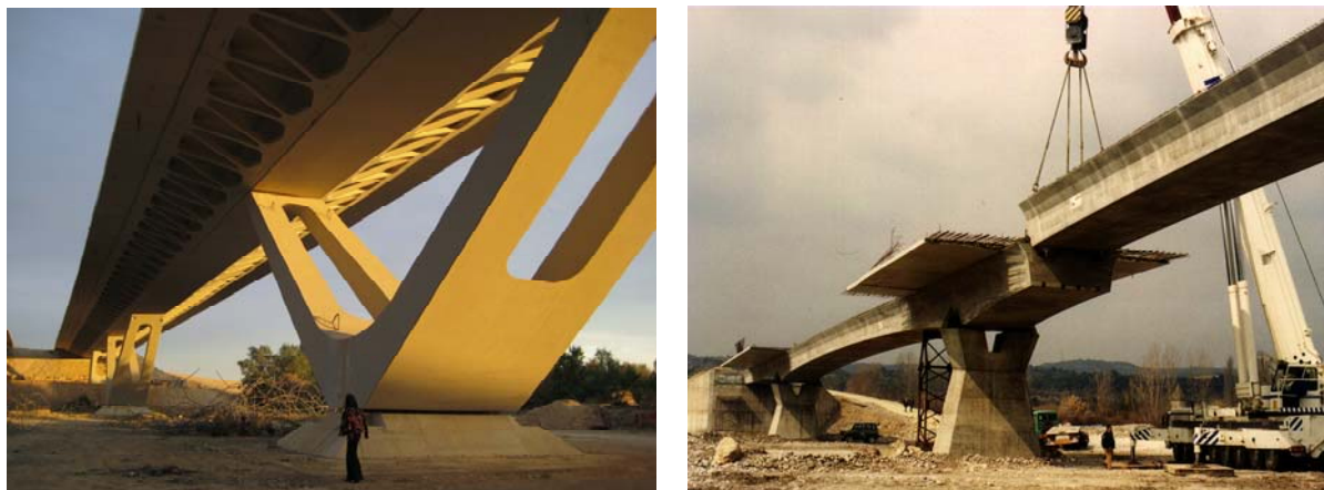
Figura 1. Puentes prefabricados continuos de hormigón postensado de medias y grandes luces
