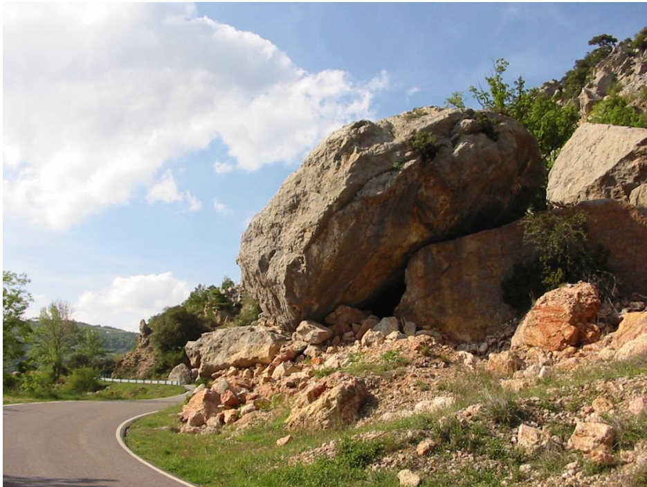
Un aspecte dels blocs caiguts sobre la carretera
