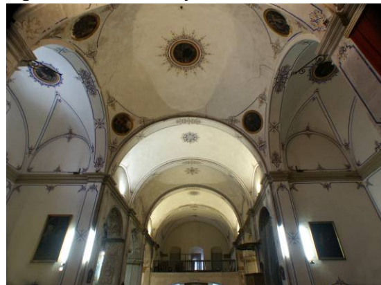
Figura 2. Nave central y crucero
