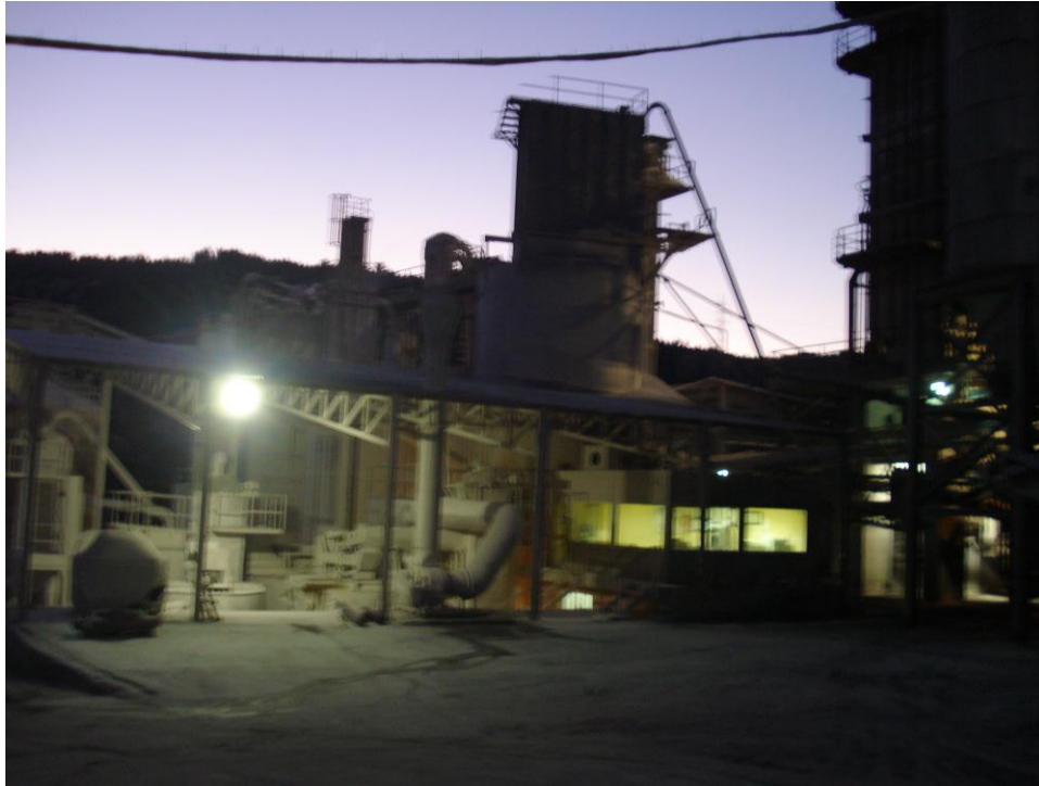
Un aspecte de les instal·lacions de la pedrera
