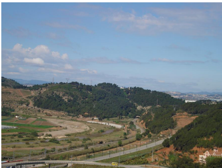
Al fons es veu el túnel de la falla del telègraf
