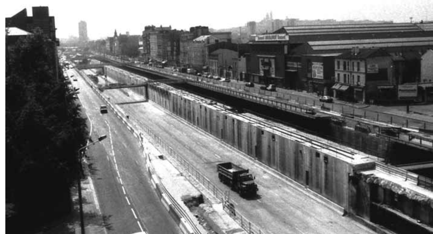
COBERTURA DE LA AUTOPISTA SAINT-DENIS
