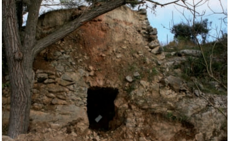
FOTO Més esvelt i modern que els forns efimers preindustrials, el Forn del Raig té forma de tronc piramidal semienterrat.
