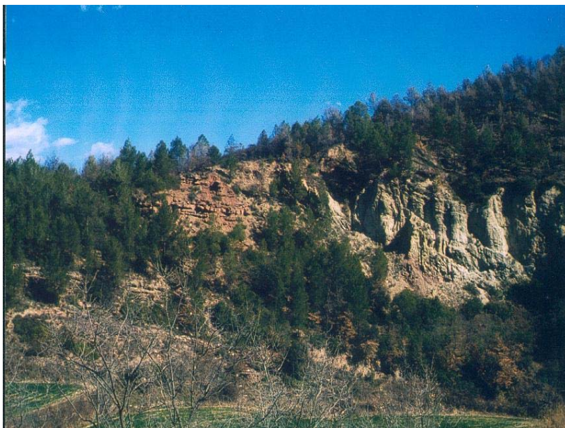
La falla del Tordell
