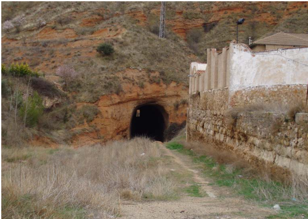
Un aspecto del túnel. Al fondo se ve la salida del mismo
