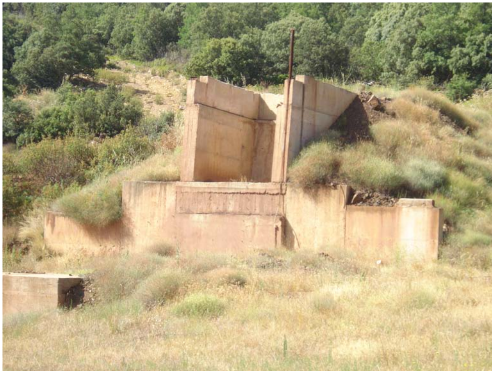
Tolvas de carga de los minerales extraídos.
