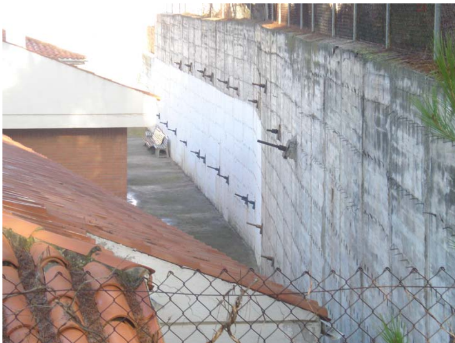
La guarderia i els murs amb els ancoratges
