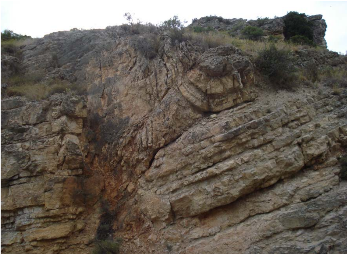
Fracturas junto a la carretera a Villanueva ( Parque Geológico de Aguilón )
